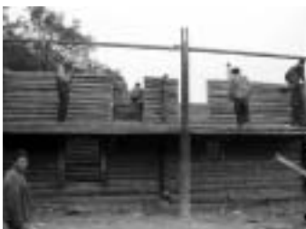
井幹式住居建設現場
